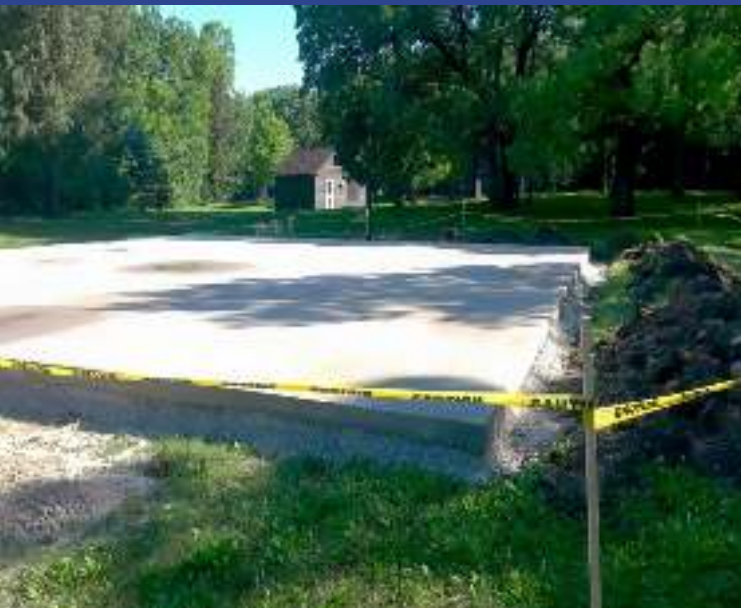
STEP1 基础浇筑
